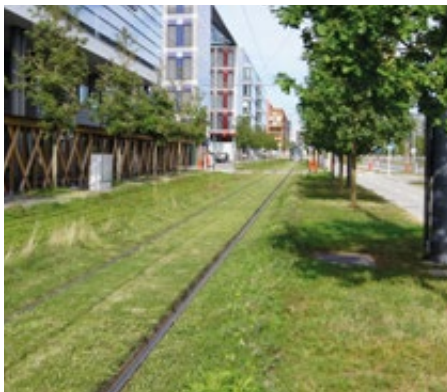
Anlage von Gleisbegrünung mit Gras
